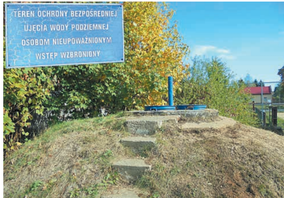
Awaria była poważna. Pierwsze symptomy – znaczny spadek ciśnienia wody w kranach – pojawiły się w lipcu. Uszkodzeniu uległa studnia numer dwa.
