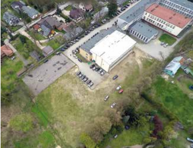
Na pustym dziś - jak widać na zdjęciu - zapleczu budynku szkoły do końca tegorocznych wakacji powstanie wielofunkcyjne boisko o poliuretanowej nawierzchni otoczone bieżnią.
