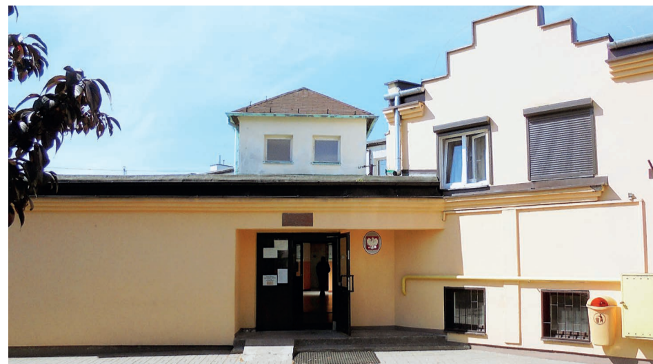
Reforma systemu oświatowego, ale i postępujący wzrost liczby mieszkańców gminy, wywołały potrzebę rozbudowy szkół. Przebudowa placówki w Justynowie rozpocząć się ma na początku wakacji i trwać będzie do końca sierpnia przyszłego roku.
