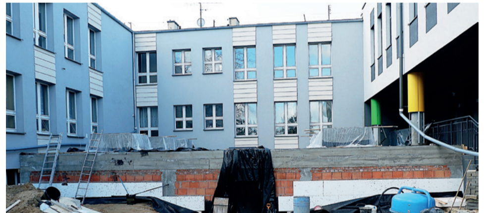
Paradoksalnie COVID-19 sprzyja budowniczym stołówki w Wiśniowej Górze. Wyłączenie szkoły z eksploatacji pozwoliło na przyspieszenie prac.
