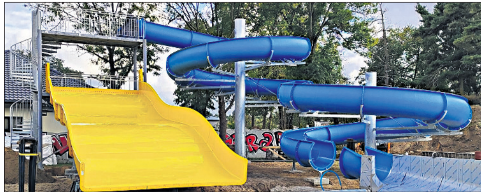
Na placu budowy basenu trwają ostatnie prace.
