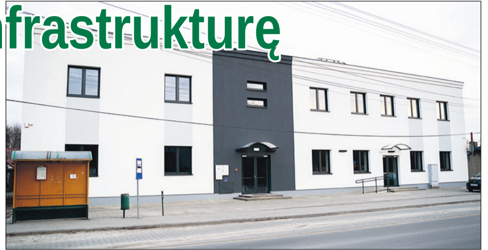
Remont Gminnego Ośrodka Kultury przy ul. Tuszyńskiej w Wiśniowej Górze kosztował w sumie 4 mln 460 tys. zł. 3 mln 490 tys. zł wydano na roboty budowlane i zagospodarowanie terenu, a 490 tys. zł na wyposażenie.
